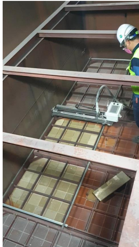
SH공사 노원열병합 Honeycomb 축매 현장 재생 모습
