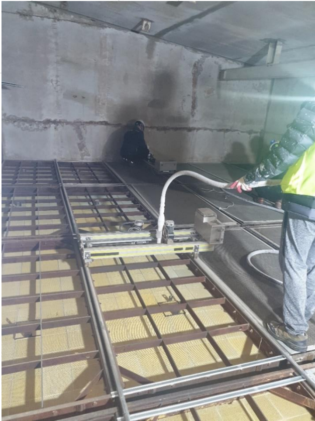
금호석유화학 제2에너지 Honeycomb 축매 현장 재생 모습
