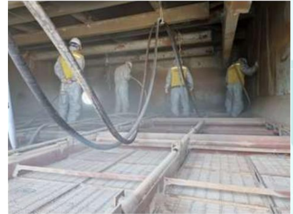
OCI SE Plate 축매 현장 재생 모습
